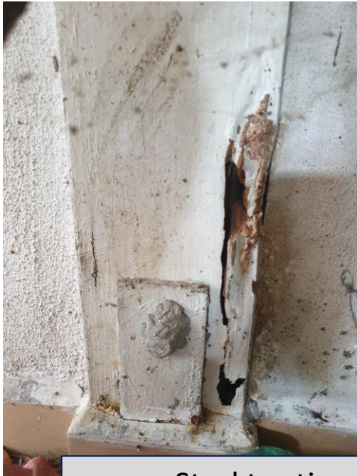
Struktur tiang kayu reput dan dinding telah renggang dan retak
