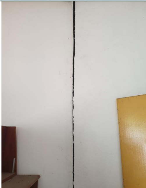
Struktur tiang kayu reput dan dinding telah renggang dan retak
