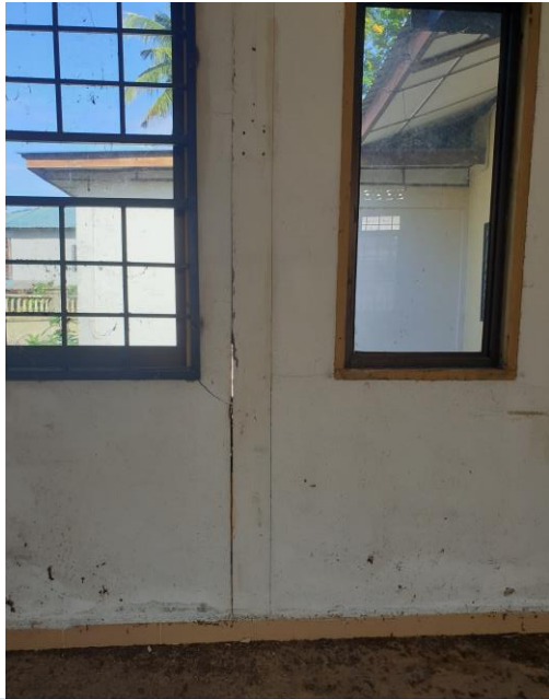
Struktur tiang kayu reput dan dinding telah renggang dan retak
