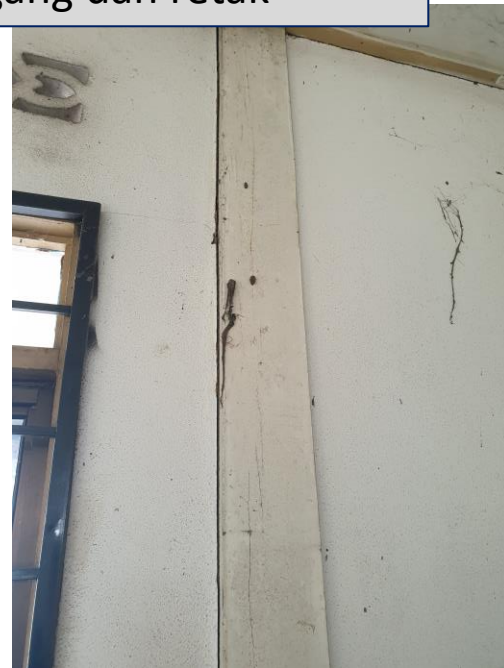
Struktur tiang kayu reput dan dinding telah renggang dan retak
