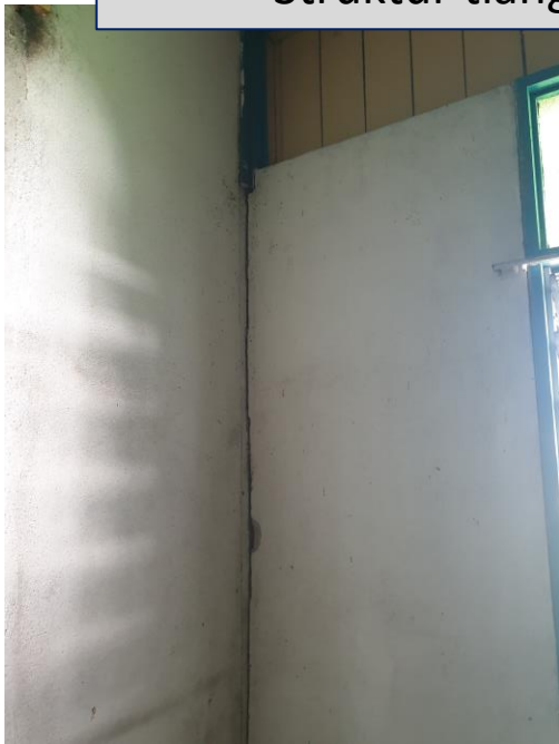
Struktur tiang kayu reput dan dinding telah renggang dan retak
